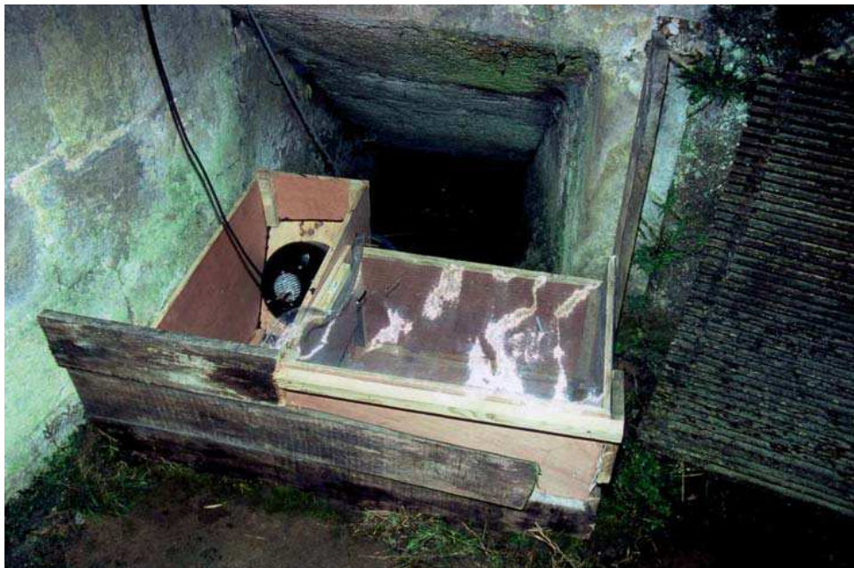
Moulin de la tannerie (Séverac-le-Château) Le 15 mars 2007 au soir, la machine Pico+@family est en place avec sa prise d'eau expérimentale. Elle est prête à délivrer 290 watts - photo JPH Azéma.
