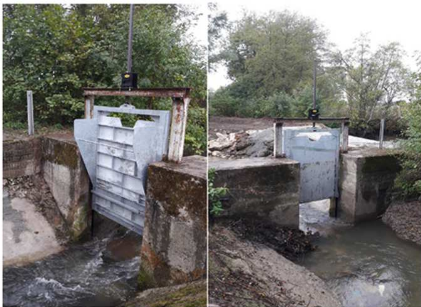
Caractéristiques Vanne PANAVAN de régulation et répartition de débits (Hauteur vanne : 2.185 * Largeur 1.554/Poids : 250 kg/hauteur d'eau à réguler : 1m85). Photo prise le jour des travaux
